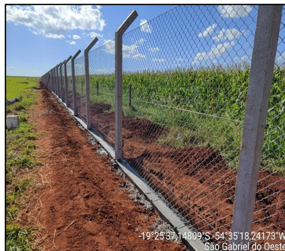
Figura 8 – Alambrado padrão ICAO.
