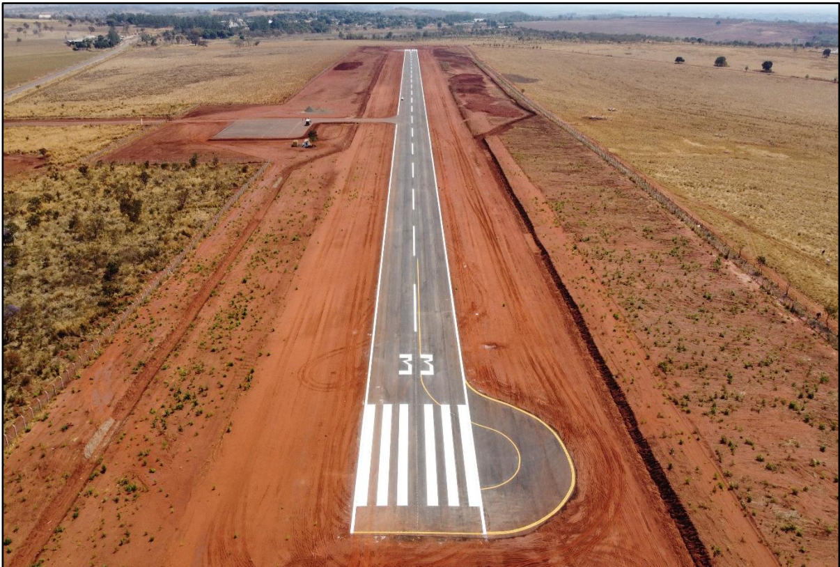
Figura 30 – Restauração do Aeródromo de Camapuã.
