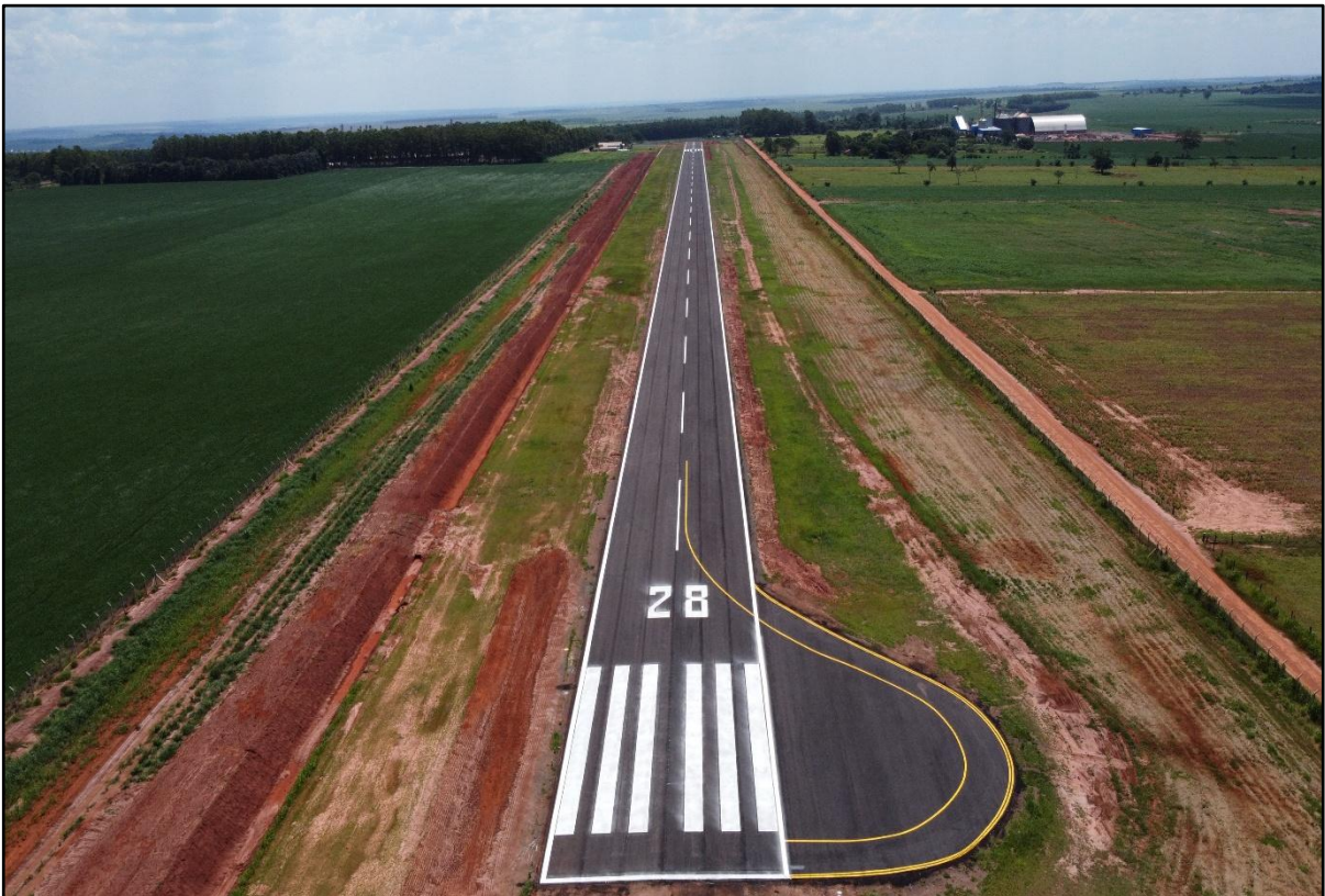
Figura 33 – Restauração Aeródromo de Naviraí.
