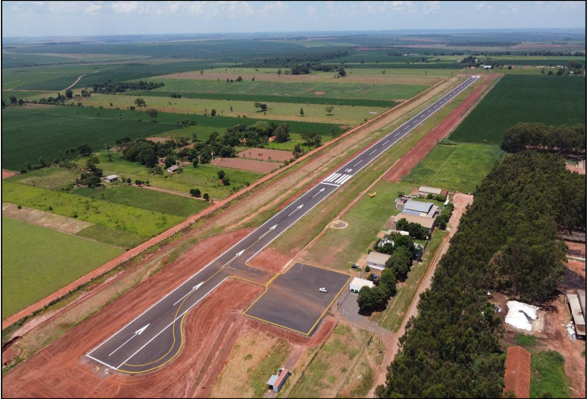
Figura 32 – Restauração Aeródromo de Naviraí.
