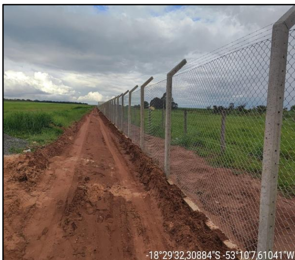
Figura 7 – Alambrado padrão ICAO.
