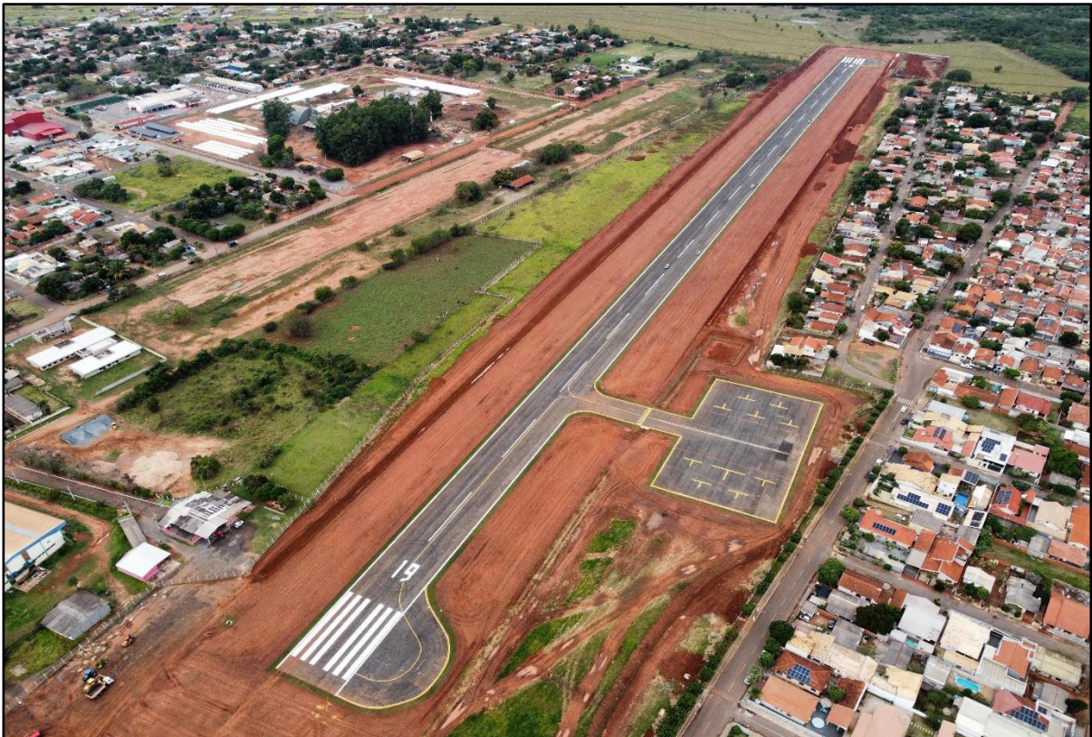
Figura 27 – Restauração do Aeródromo de Jardim.
