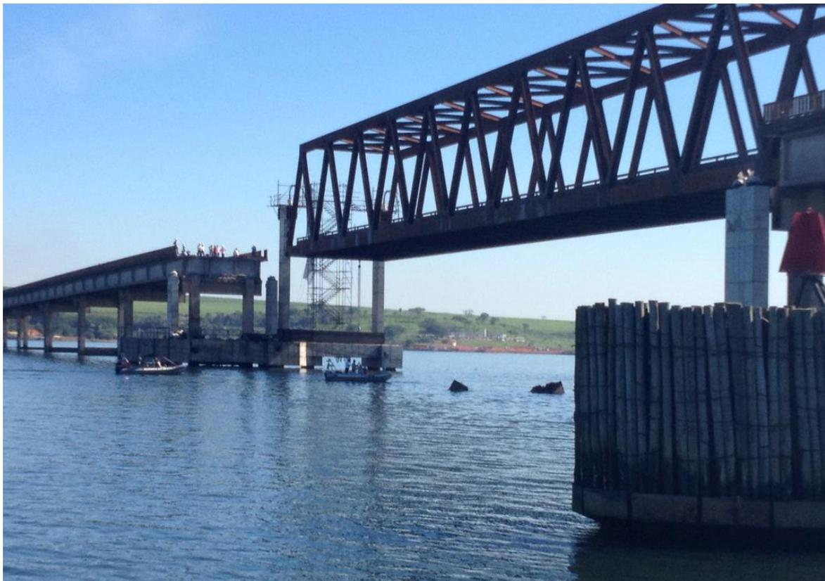
Figura 44 - Hidrovia do Tietê – ampliação de vão de ponte na SP-333
